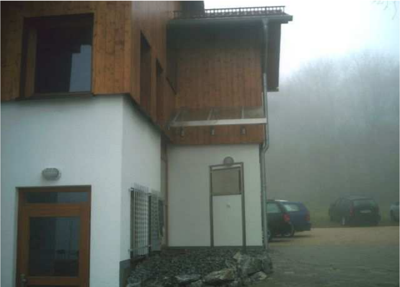
Rohrauer – Hütte nach dem Umbau im November 2010
